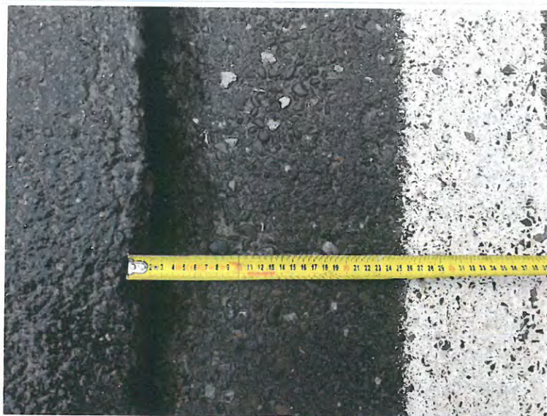
Crăpături adânci în structura rutieră;
