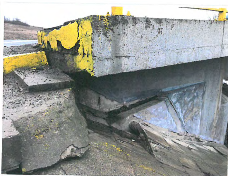
Apariția unor degradări în structura podului, zona sferului de con;
