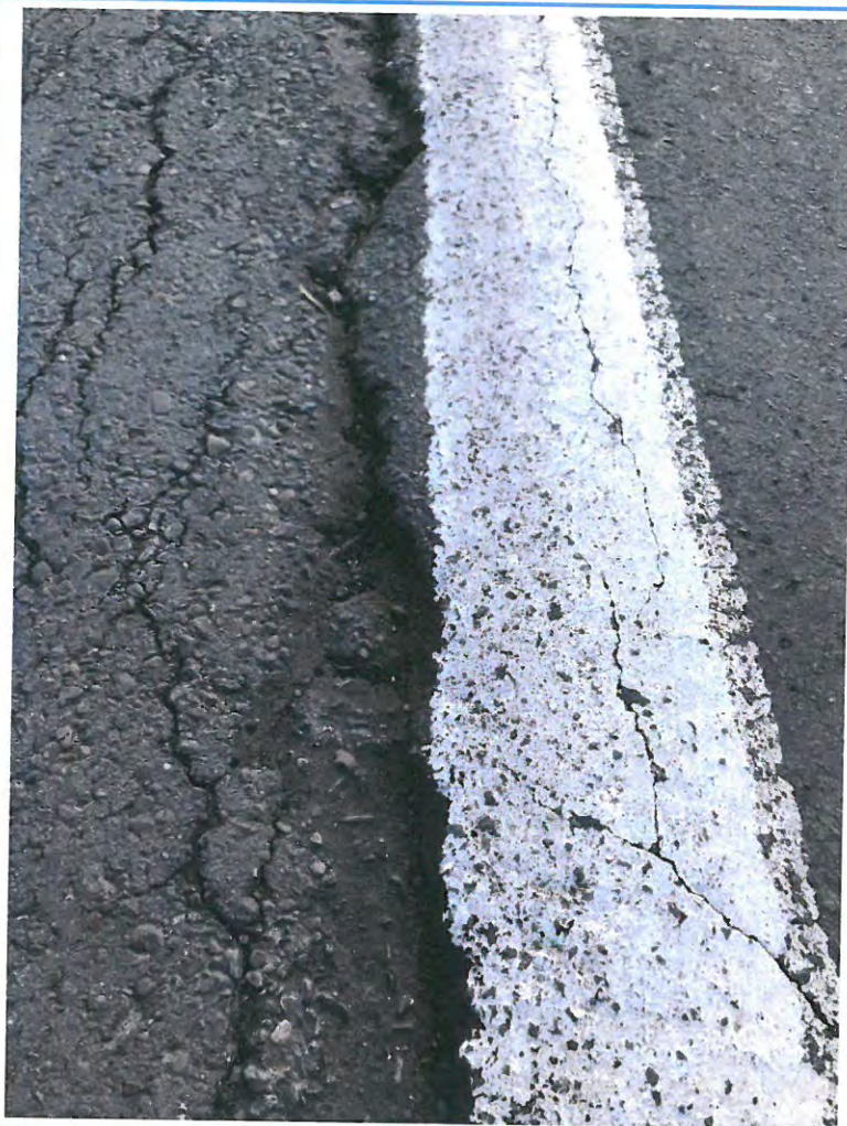
Uzura accentuată a structurii rutiere;
