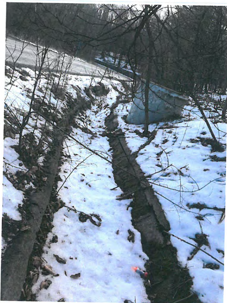
Sistemele de preluare a apelor din precipitații sunt colmatate și degradate;
