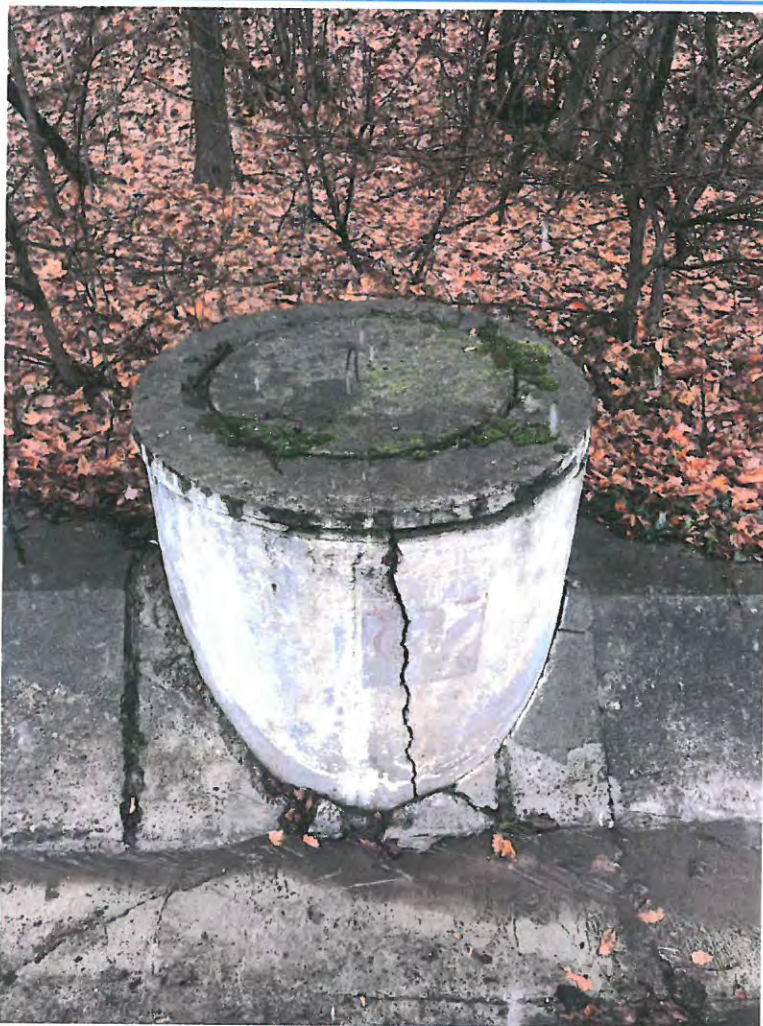
Sisteme de preluare a apelor din precipitații (drenuri) degradate;
